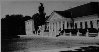
Котовка. Южный фасадъ дома.
