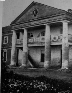
Средняя часть фасада „красного дома“ (на рѣку).
