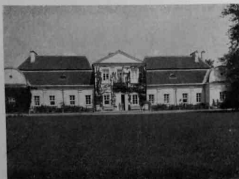
Имѣніе „Дорогускъ“. Фасадъ стараго усадебнаго дома.
