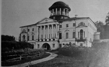
Фасад дома в Покровском, со стороны подъезда. (Правая половина пристройки).
