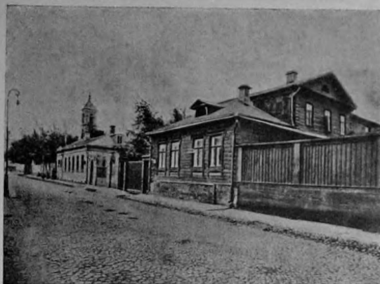
Домъ Григорьевыхъ въ Москвѣ, на Малой Полянкѣ, у Спаса въ Наливкахъ, въ Замоскворѣчѣ. (Съ фотографіи 1915 г., принадлежащей Пушкинскому Дому при Имп. Академіи Наукъ).
